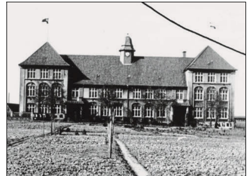
Die Sudbrackschule um 1930: Mit dem Bau war bereits vor dem Ersten Weltkrieg begonnen worden. Foto: Sammlung von Hollen
